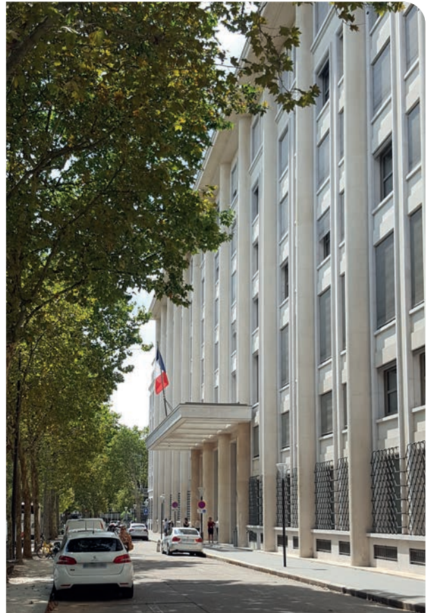
Locaux de la direction des services administratifs et financiers (DSAF), 20 avenue de Ségur, Paris.
