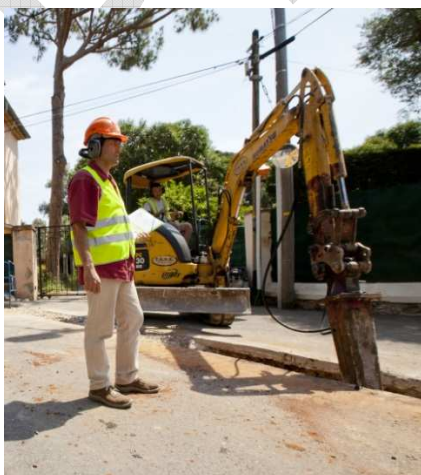
BRH monté sur mini-pelle
